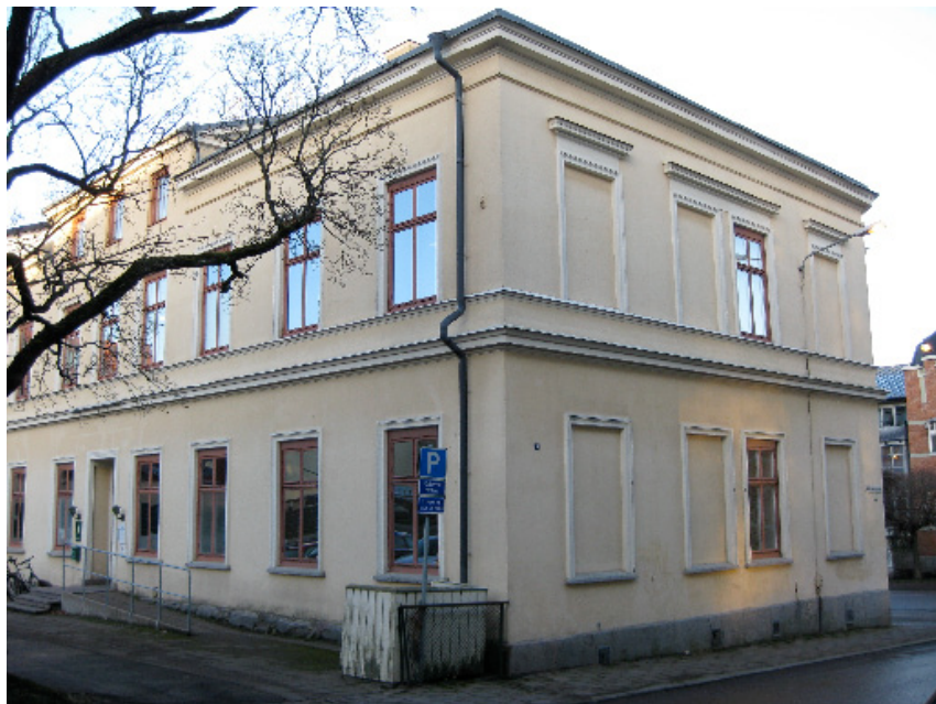
Norra Skolans igenmurade fönster på fasaden mot Norra Kyrkogatan ger en känsla av bakgård mot gaturummet. Foto: Karlstad Lever 2008.
