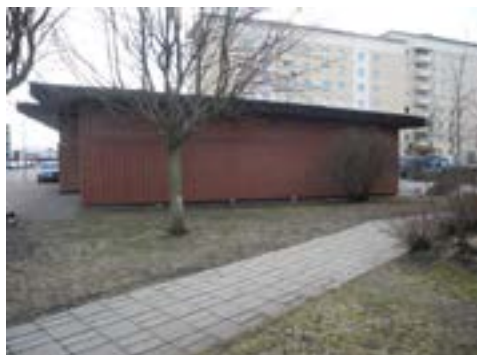
Fastighetens norra del. Gångbana tillhör grannfastigheten Bjälken 4.
