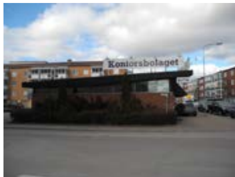
Byggnadens södra fasad.
