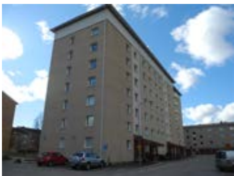
Sydvärnsgatan 2-3 (Bjälken 2). Gavel mot Stenhagsgatan.
