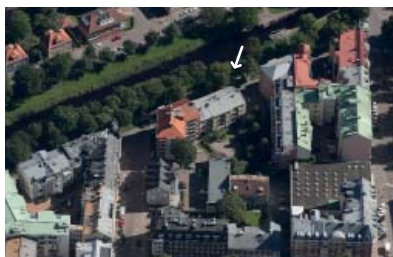
Byggnaden sett från öster
