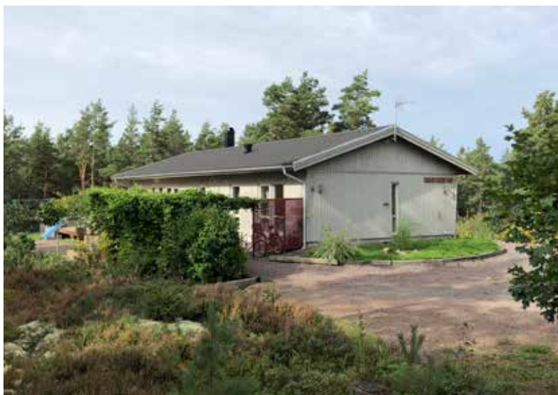
Befintlig byggnad på fastigheten Randviken 1:31
