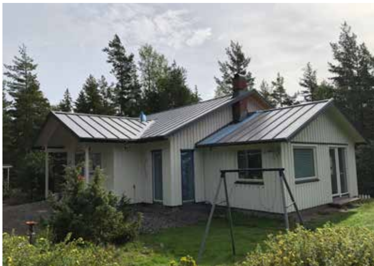
Befintlig byggnad på fastigheten Randviken 1:39
