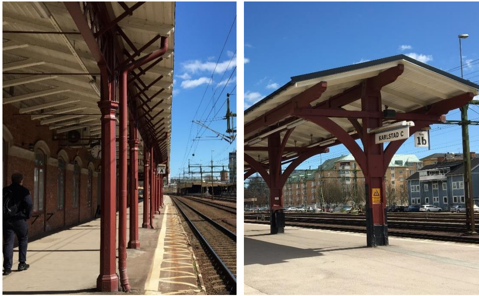
T.v. Äldre perrongtak med bärande gjutjärnskonstruktion, t.h. den s.k. Törebodamodellen av limträ.
